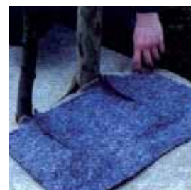
4. Prévoir un recouvrement
