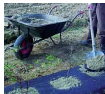
maintenir en place le film et la collerette avec une pelletée de sable ou de gravier
