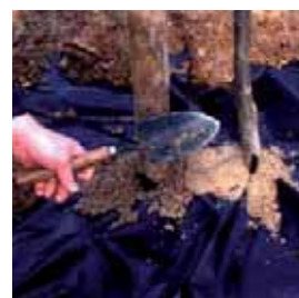
4. Epandre du sable
