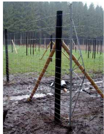
pose et tension du treillis
